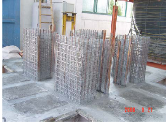
照片 2 一层施工
