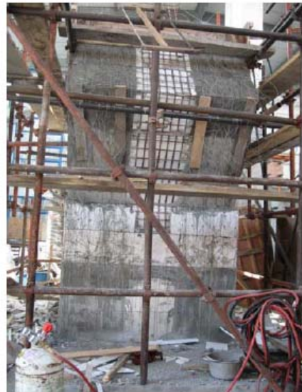
照片 12 侧立面（施工至 10 层）
