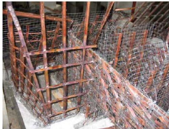
照片 10 十层以上施工
