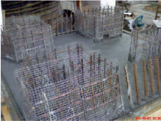
照片 3 二层施工
