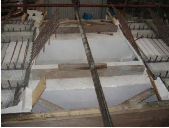
照片 7 八层平面施工
