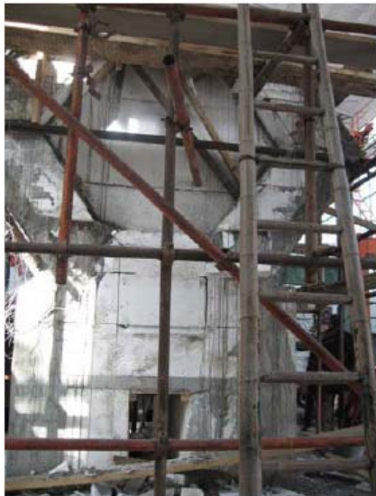
照片 11 正立面（施工至 10 层）
