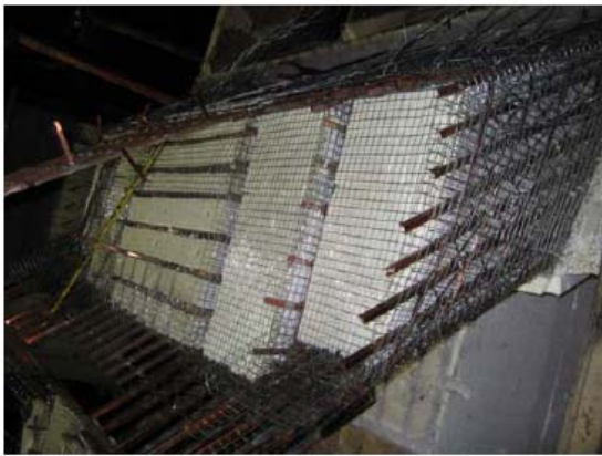
照片 9 九层施工
