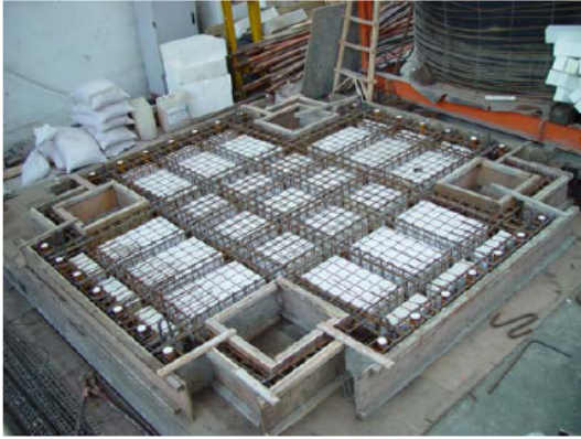
照片 1 底座施工
