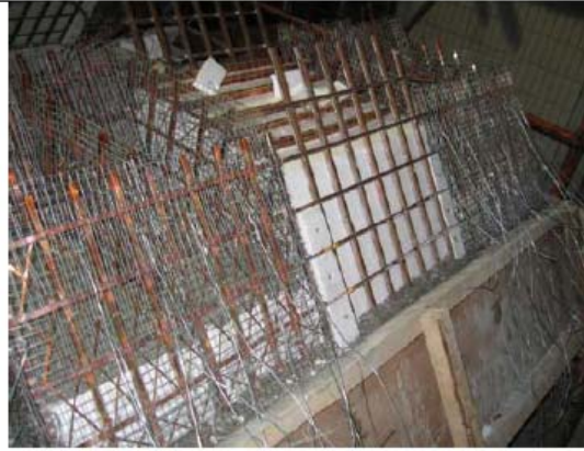
照片 8 八层施工
