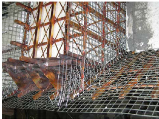
照片 6 七层局部加强施工
