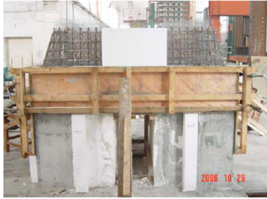
照片 4 三层施工
