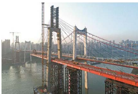
重庆鹅公岩轨道交通专用桥施工现场图
